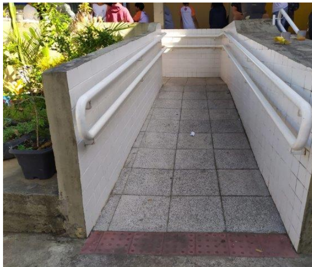
Foto 2 – Rampa - vista do nível +0,80
